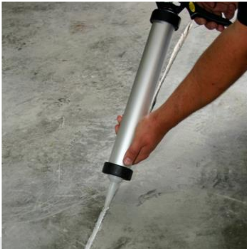
Foto: Aanbrengen voegmassa.
